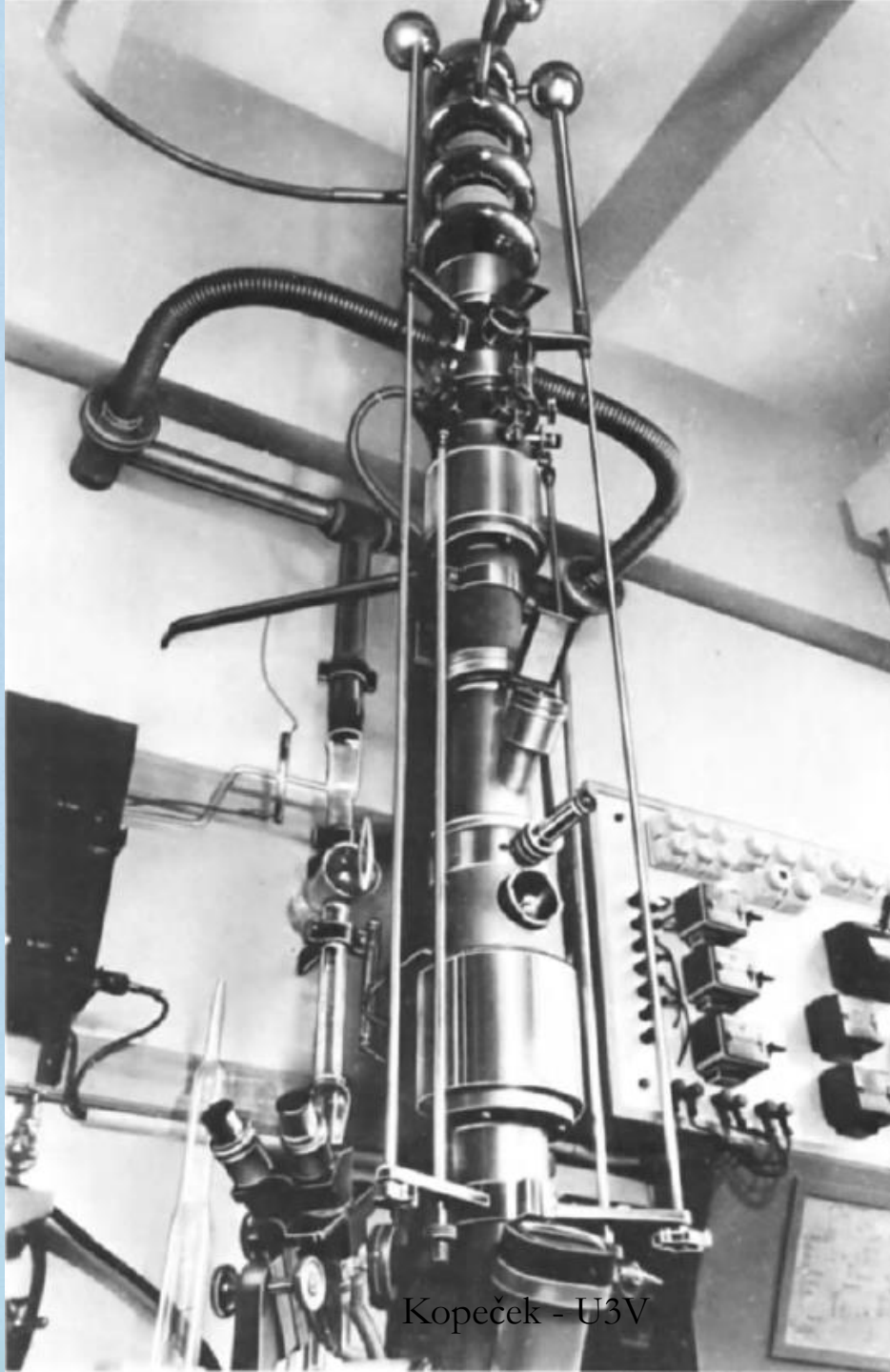
Univerzální elektronový mikroskop pro energie 200 až 300 keV, M. von Ardenne, 1941-43
